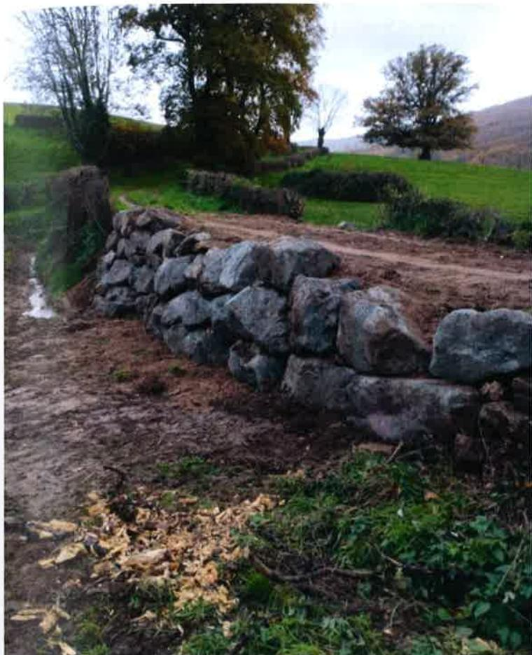
**Le chemin de la Praye** a bénéficié d'une rénovation urgente de son ouvrage hydraulique, qui était très dégradé par le temps. Par la même occasion, le consolidation de son soutient a été réalisé par un empierrage. Les travaux réalisés se sont élevés à 15 901,94 € TTC
