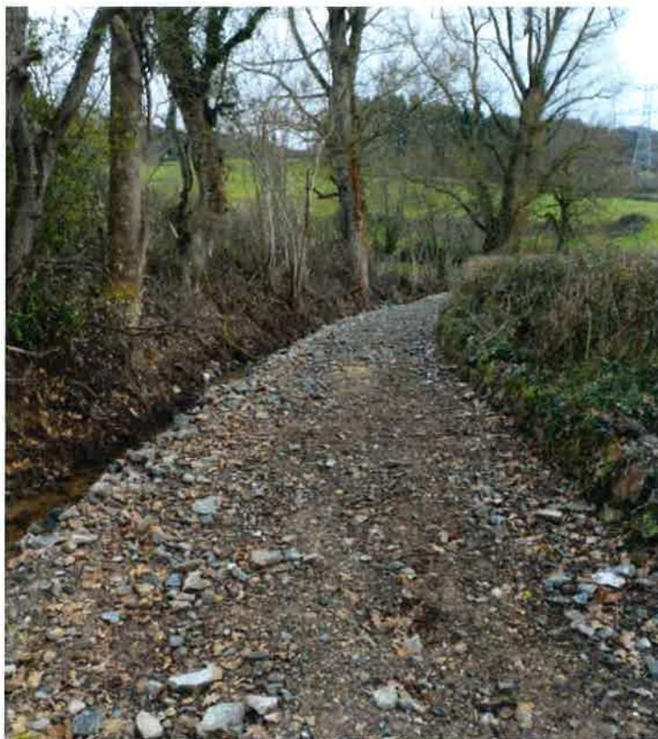
**Le chemin de Doriers** a été rénové sur une portion importante, qui était très abîmée par le passage de l'eau. Une reconstruction de ce dernier avec la mise en place d'empierrement et d'un fossé pour canaliser le passage du guet, ont été réalisés. Ce chemin qui était jusqu'alors impraticable est de nouveau rouvert à la circulation. Les travaux réalisés se sont élevés à 9 545,88 € TTC
